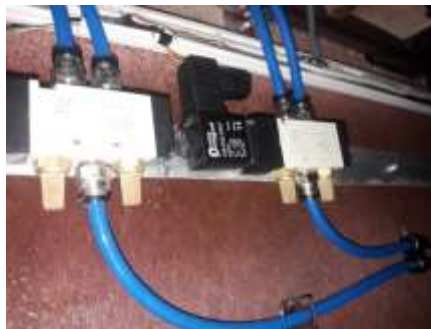
Figura 19. Electroválvulas Monoestables
