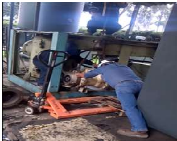
Figura 47: Montaje de la unidad de aire. Elaboración: Fuente propia (2018)
