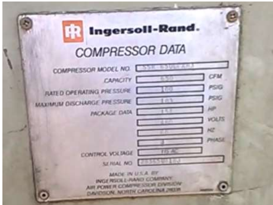
Figural 1: Datos del compresor Ingersoll-Rand. Fuente: Elaboración propia (2018)
