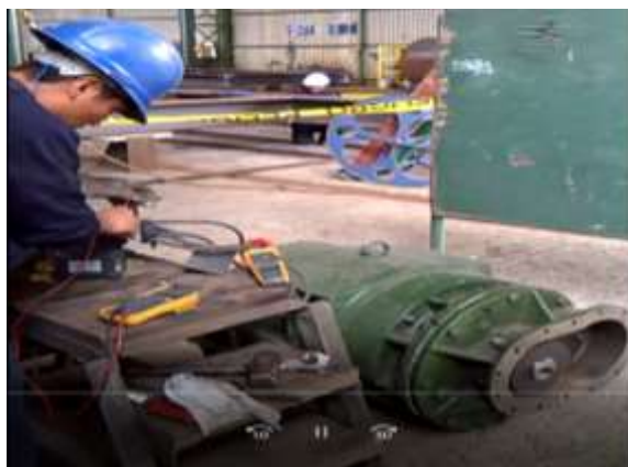
Figura 37: Prueba de funcionamiento en vacío Elaboración: Fuente propia (2018)
