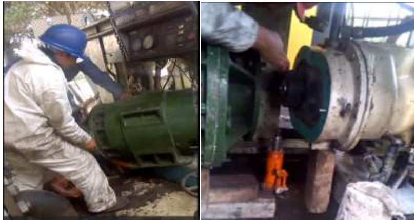
Figura 48: Montaje y Acoplamiento del motor y la unidad. Elaboración: Fuente propia (2018)
