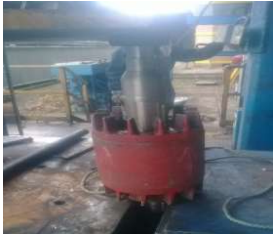
Figura 30: Montaje del eje en la jaula de ardilla. Elaboración: Fuente propia (2018)
