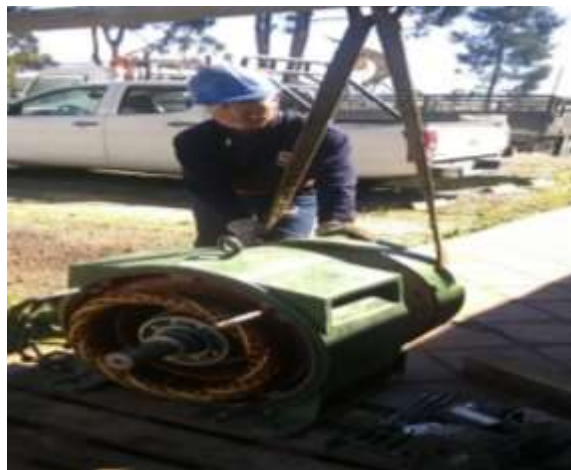
Figura 34: Montaje del rotor en el estator Elaboración: Fuente propia (2018)
