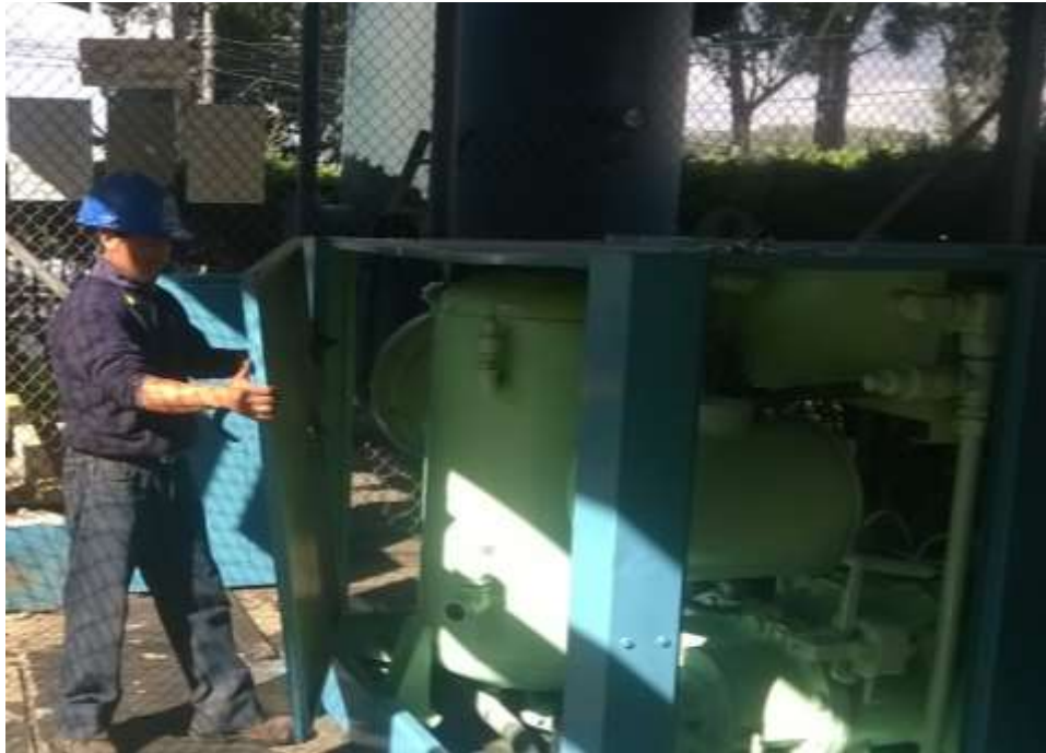
Figural 6: Armado de estructura de protección. Fuente: Elaboración propia (2018)
