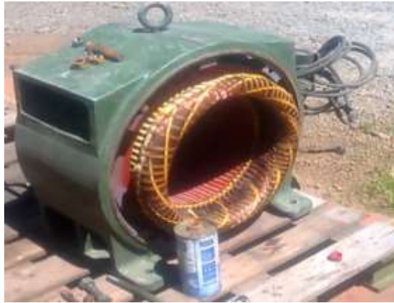
Figura 33: Limpieza y barnizado del estator. Elaboración: Fuente propia (2018)
