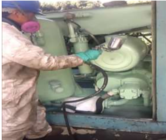
Figura 52: Pintado de la estructura Fuente: elaboración propia (2018)
