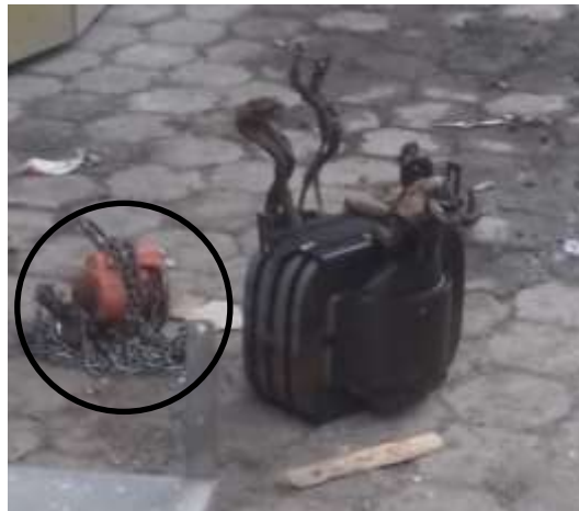
Figura 50: Núcleo desprendido del tanque mediante tecele de 1 Ton (Lenin, 2017)
