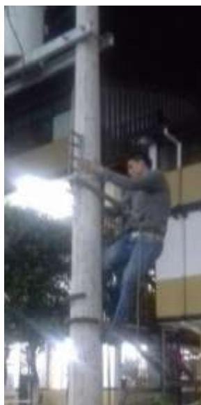
Figura 45: Anclaje de racks de soporte (Lenin, 2017).
