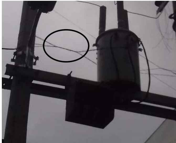
Figura 42: Posicionamiento de transformador con alambre de acero (Lenin, 2017).
