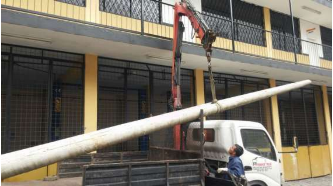
Figura 32: Colocación de postes con grúa telescópica de 12m (Lenin, 2017).
