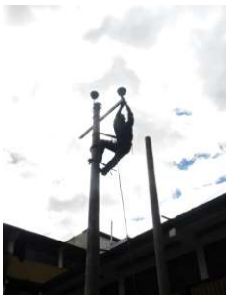
Figura 35: Colocación de estructura para aisladores tipo espiga (Lenin, 2017)
