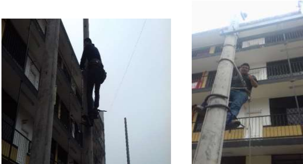
Figura 36: Ascenso para aseguramiento de estructura (Lenin, 2017)
