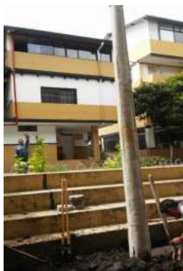
Figura 33: Alineación de postes (Lenin, 2017).
