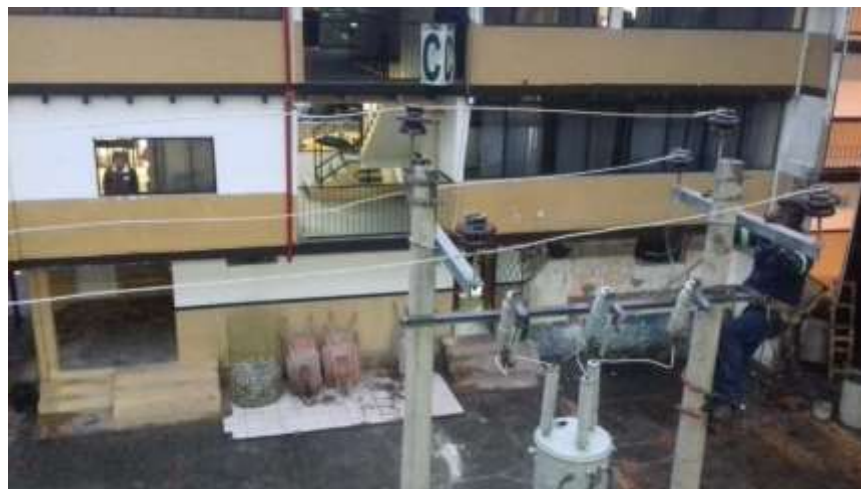
Figura 46: Puesta de líneas de alta tensión (Lenin, 2017).
