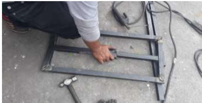
Figura 34. Construcción de la base para las chumaceras
