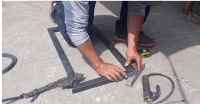
Figura 33. Construcción de base con tubo de 1"1/4
