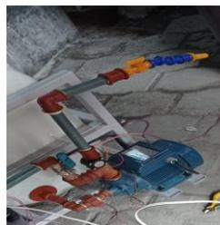
*Nota.* En la imagen se muestra la tubería de  $\frac{1}{2}$ '' y codos que han sido implementados en el sistema.
