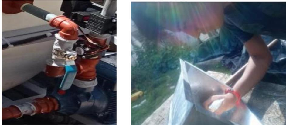
*Nota.* En la figura se puede verificar la colocación del sellante gris tanto en la parte del tamizador como en las tuberías, solucionando así el único inconveniente que se encontró durante la construcción del proyecto.
