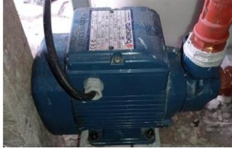
*Nota.* En la figura se muestra la bomba periférica con una potencia de 650 W y un flujo máximo o caudal de 5-60 l/min.
